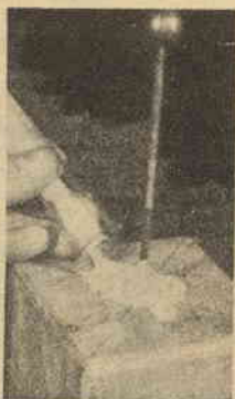
Il conduttore va bloccato con zolfo fuso
